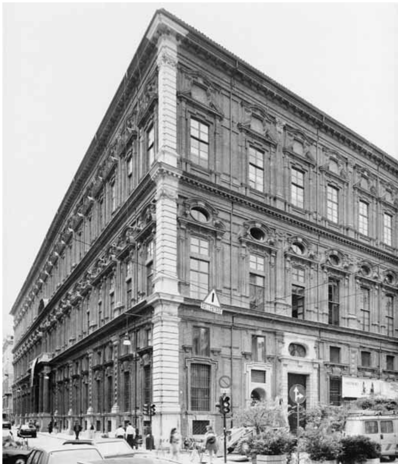
260. Turin, Collegio dei Nobili, Straßenfassade.
